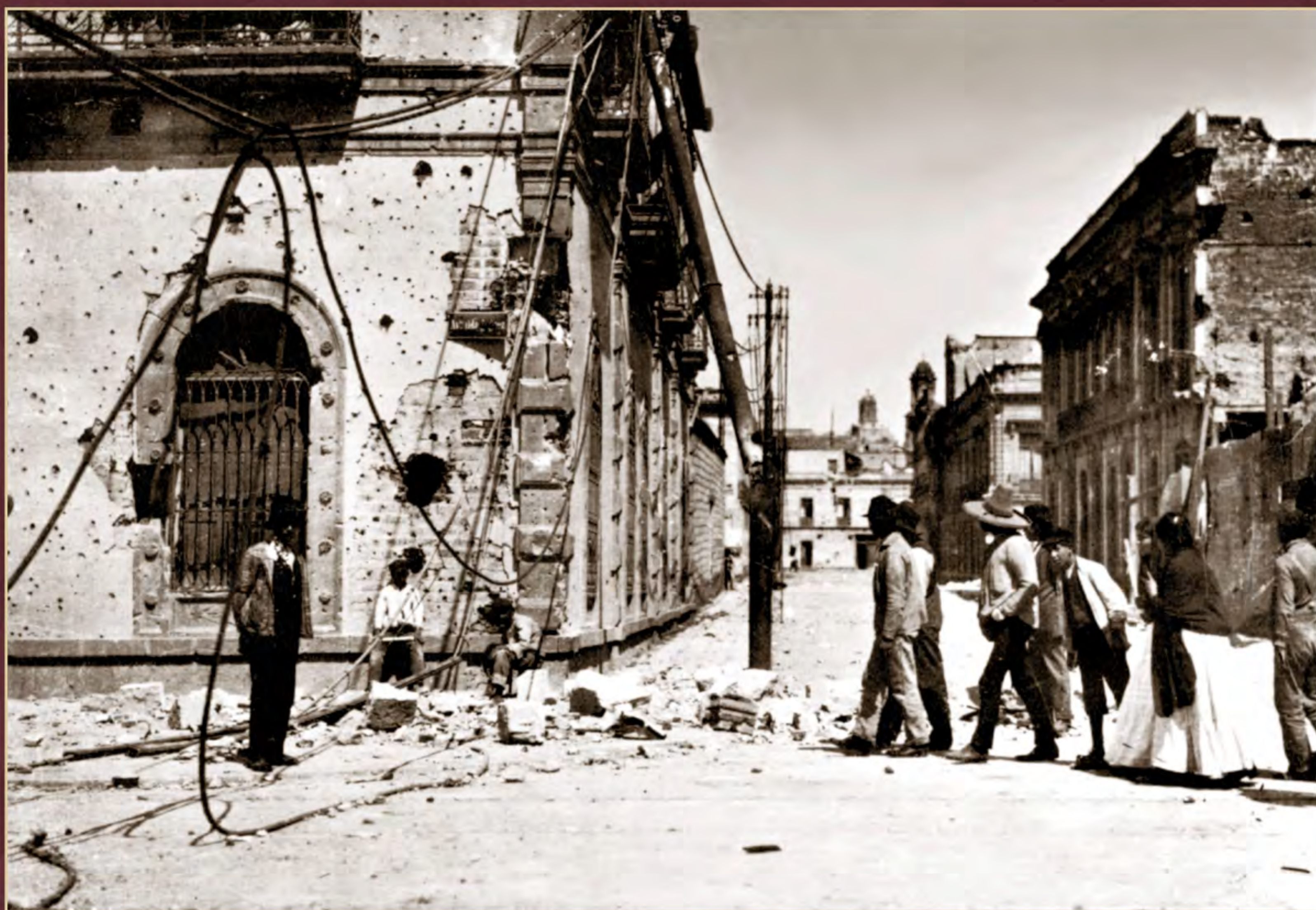
Edificios de la Avenida Juárez dañados durante los combates de la Decena Trágica, febrero de 1913.
